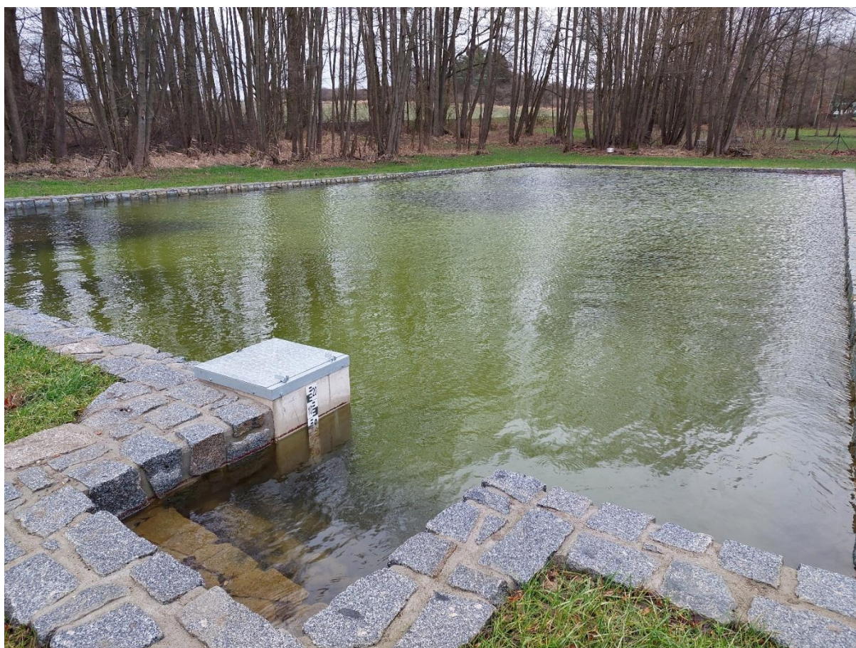
Udržovací práce požární nádrže Pašovice
