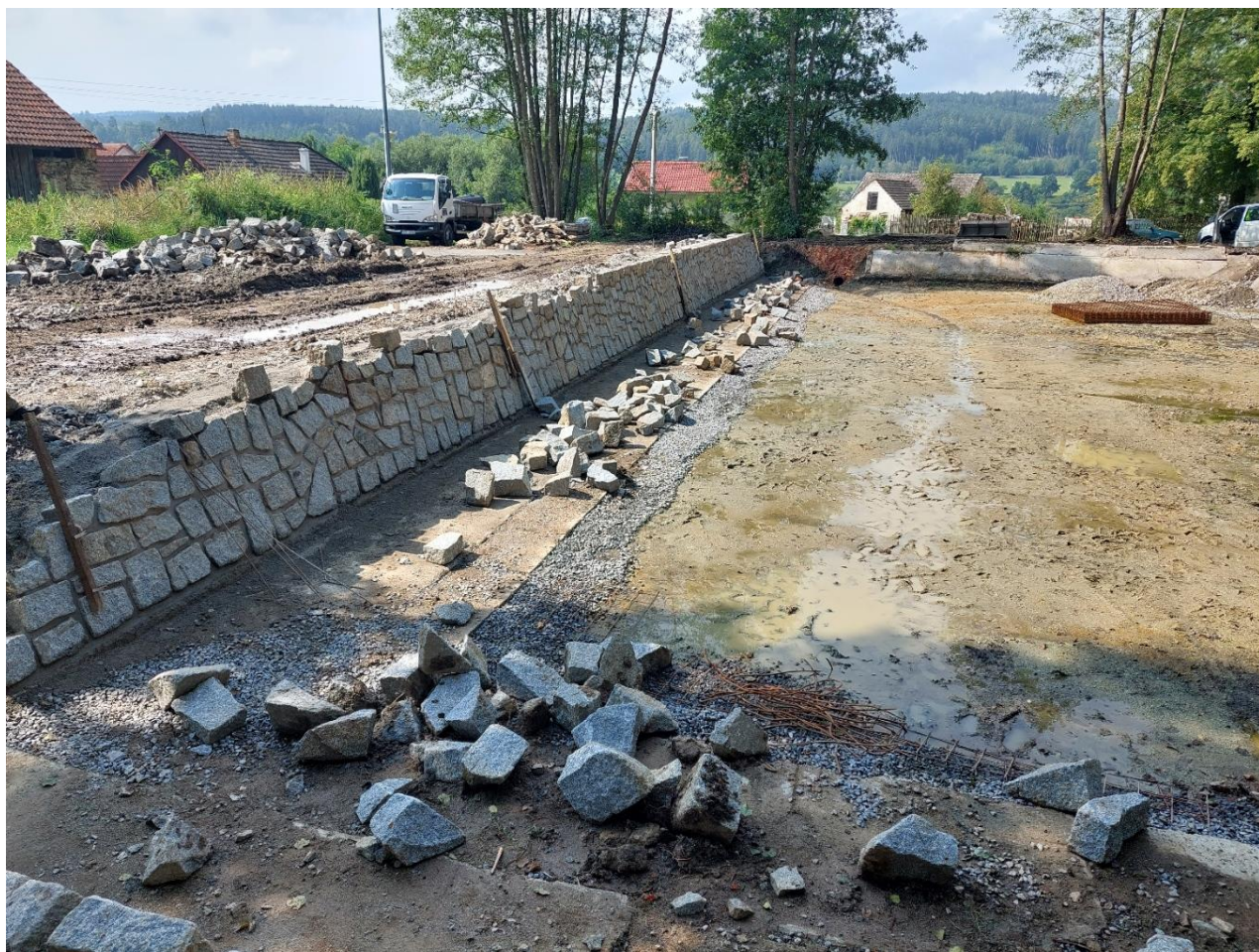
Udržovací práce požární nádrže Pašovice
